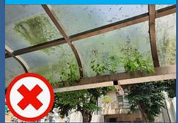
屋簷的排水槽(天溝)
