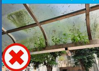
屋簷的排水槽(天溝)
